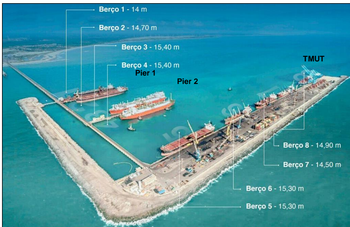
Figura 3.10 – Piers e berços de atracação do Porto do Pecém
